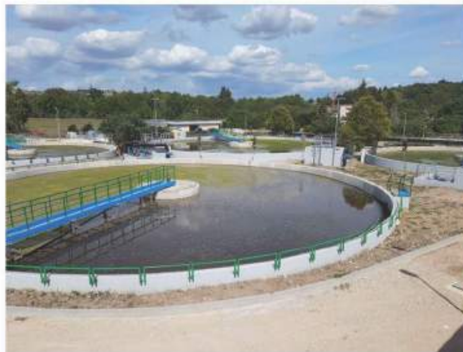
- Impianto di depurazione di Matera località Pantano
